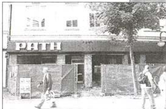
Nach fünf Monaten Leerstand ertönt aus den ehemaligen Räumen des Modehauses Path Baulärm: Schon Anfang 2007 soll hier ein neues Bekleidungsgeschäft einziehen.
