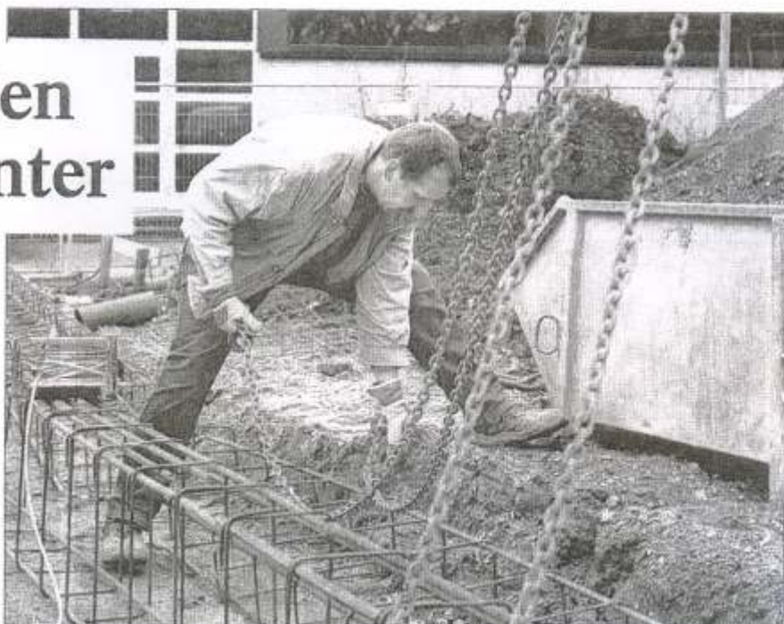
Eigentlich wäre jetzt im Winter Urlaubszeit für Andreas Kröger (47). Bei den milden Temperaturen jedoch bereitet er die Bewehrung am Städtischen Gymnasium für den Neubau vor.
