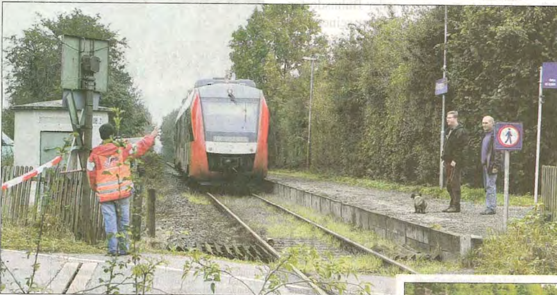
Flutterband hin, Flatterband weg: Am Altengörser Bahnhof staunen Peter und Thomas Rottgardt, wie derzeit die Lichtzeichenanlage ersetzt wird (gr. Bild). Unten: Mit einem Flatterband wird zurzeit auch der Bahnübergang am Wirtschaftsweg gesichert. Dort war am 15. Juli 2004 der Fahrer eines Baggers von einem Zug getötet worden. Ein Kreuz erinnert an das tragische Unglück.
