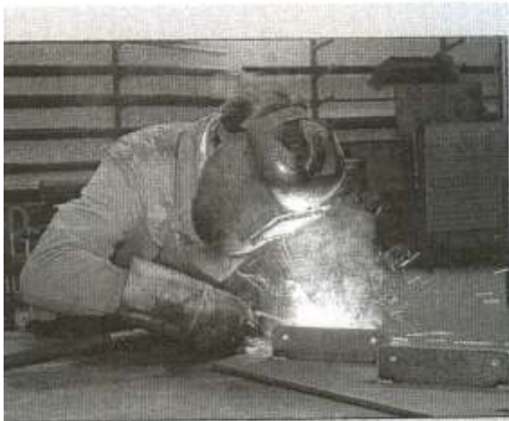
Auf der Messe werden die Besucher den Handwerkern über die Schulter schauen können – wie Thorsten Becken von der Firma T+B-Stahlbau beim Schweißen eines Treppengerüsts.
