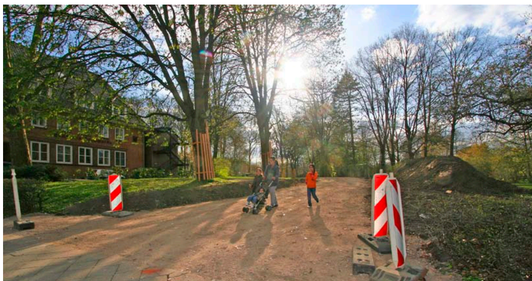
Nur für die Bauphase wurde eine separate Bauzufahrt durch den Kurpark angelegt.
